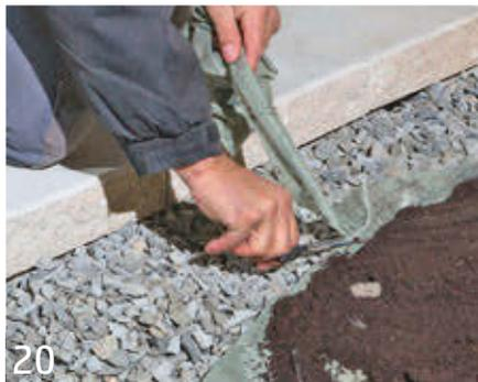
Füllen Sie den Drainagesplitt mindestens bis zur Unterkante der Abdeckplatte an. Das Vlies trennt Drainagesplitt und Schotter von dem Erdreich. Sprechen Sie mit Ihrem Gärtner, wie dick die Erdschicht zum Bepflanzen sein muss.
