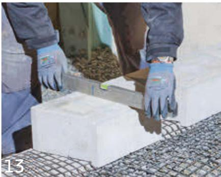
13 Minimale Höhenunterschiede bei den Mauersteinen können mit Sand, Körnung 0/2 mm, oder passenden Montageblättchen aus Plastik ausgeglichen werden. Dies gilt auch für minimale Höhenunterschiede, die durch den Einbau des Geogitters bedingt sein können.
