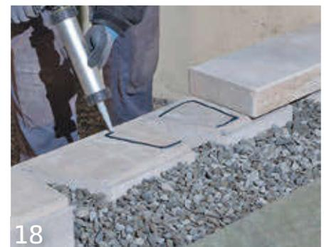
18 Die Abdeckplatten sind durch Verkleben gegen Entnahme zu sichern. Nehmen Sie zum Verkleben einen dafür geeigneten Kleber, der schrumpffrei, elastisch, temperatur- und witterungsbeständig ist. Bei dem Trockenmauersystem sollten die Fugen zwischen den Abdeckplatten dauerelastisch abgedichtet werden. Fluchten Sie die Abdeckplatten bestenfalls mit einer Richtschnur, einer Richtlatte oder einer langen Wasserwaage aus.
