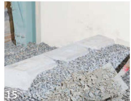
15 Wichtig ist die lagenweise Verdichtung des Hinterfüllmaterials. Überdecken Sie das Geogitter mit mindestens 10 cm Schüttmaterial, bevor Sie mit dem Verdichten beginnen. Verdichten Sie lagenweise (Schichtstärke 10–15 cm) mit geeignetem Gerät. Der Drainagesplitt hinter der Mauer muss nicht verdichtet werden. Bleiben Sie mit der Rüttelplatte ca. 30 cm von der Hinterkante des Mauerwerks entfernt.
