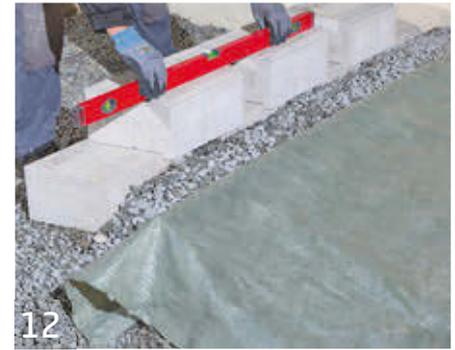
12 Kontrollieren Sie fortlaufend die Flucht der Mauer und überprüfen Sie, ob die Steine sich in gleicher Höhenlage befinden und eben sind. Treten Sie ein paar Meter zurück und überprüfen Sie den Fugenverlauf der Mauer. Fehler oder Ungenauigkeiten können jetzt noch gut korrigiert werden.
