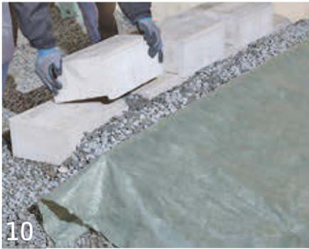
10 Setzen Sie den Stein vorsichtig auf die untere Steinlage. Die Steine dieses Mauersystems werden im Halbverband gesetzt.
