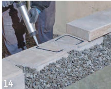
14 Sichern Sie die Abdeckplatten durch Verkleben gegen Entnahme. Verwenden Sie einen geeigneten Kleber, der schrumpffrei, elastisch, temperatur- und witterungsbeständig ist. Bei dem Trockenmauersystem sollten die Fugen zwischen den Abdeckplatten dauerelastisch abgedichtet werden. Fluchten Sie die Abdeckplatten mit einer Richtschnur, einer Richtlatte oder einer langen Wasserwaage aus.
