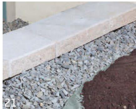
Sie können die erforderliche Schichtdicke des Erdreiches über dem Drainbeton einbauen (siehe Detail A Bild 17). Schneiden Sie dann mit geeignetem Werkzeug das Vlies ab. Es ist eine Stützmauer entstanden, welche Ihnen lange Freude bereiten wird.
