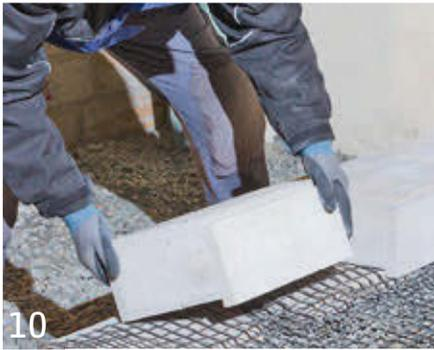
10 Setzen Sie den Stein vorsichtig auf die untere Steinlage. Die Steine dieses Mauerwerksystems werden im Halbverband gesetzt. Die erforderliche Länge des Geogitters können Sie den Tabellen entnehmen. Das Geogitter wird in jeder zweiten Steinreihe eingebaut, der vertikale Abstand beträgt 30 cm.
