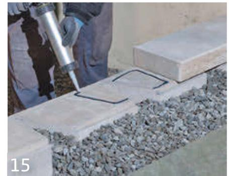
15 Die Abdeckplatten sind durch Verkleben gegen Entnahme zu sichern. Nehmen Sie zum Verkleben einen dafür geeigneten Kleber, der schrumpffrei, elastisch, temperatur- und witterungsbeständig ist. Bei dem Trockenmauersystem sollten die Fugen zwischen den Abdeckplatten dauerelastisch abgedichtet werden. Fluchten Sie die Abdeckplatten bestenfalls mit einer Richtschnur, einer Richtlatte oder einer langen Wasserwaage aus.
