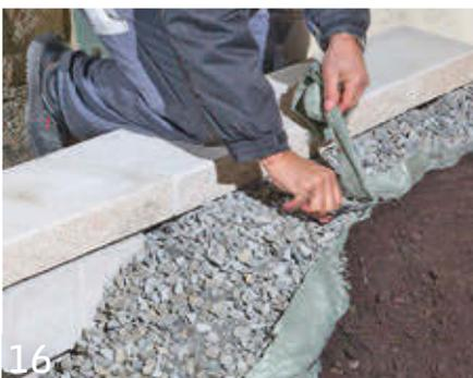
16 Füllen Sie den Drainagesplitt mindestens bis zur Unterkante der Abdeckplatte an. Das Vlies trennt den Drainagesplitt von dem Erdreich. Sie können die erforderliche Schichtdicke des Erdreiches über dem Schotter einbauen. Schneiden Sie dann mit geeignetem Werkzeug das Vlies ab.
