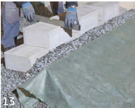
13 Minimale Höhenunterschiede bei den Mauersteinen können mit Sand, Körnung 0/2 mm oder passenden Montageblättchen aus Plastik ausgeglichen werden. Wiederholen Sie die Arbeitsschritte, bis Sie oben bei der Mauer angekommen sind.
