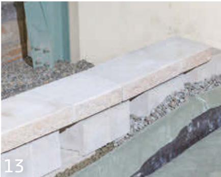
13 Je nachdem wie der Platz oberhalb der Stützmauer genutzt wird, ist dort auch eine Bepflanzung möglich. Zwischen Drainbeton und Erdreich muss horizontal ein Filtervlies eingebaut werden. Hinter der Mauer wird in einer Breite von ca. 25 cm Drainagesplitt der Körnung 8/16 mm eingebaut.
