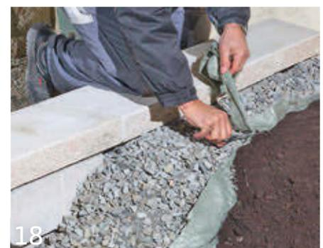
18 Sie können dann die erforderliche Schichtdicke des Erdreiches über dem Schotter einbauen. Schneiden Sie dann mit geeignetem Werkzeug das Vlies ab. Es ist eine Stützmauer entstanden, die Ihnen lange Freude bereiten wird.
