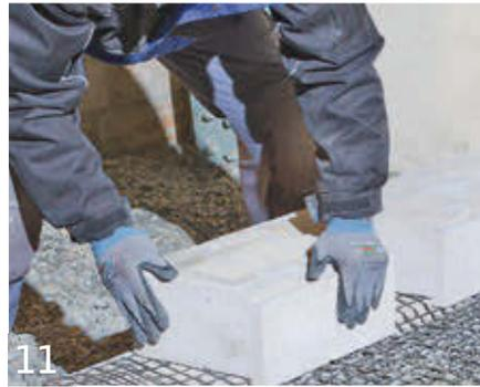
11 Richten Sie den Stein aus und ziehen sie ihn solange in Ihre Richtung, bis die Haltenase bündig an dem darunterliegenden Stein sitzt.
