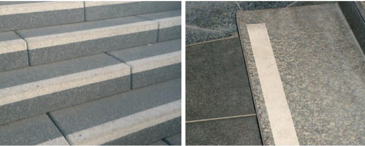
Treppenstufenmarkierung mit integriertem Kantenlement (links) und nachträglicher Applikation (rechts)
