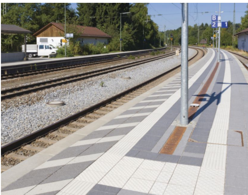
Blick auf die Bahnsteigkante mit Schraffur im Gefahrenbereich in rinit Basalt mit sandgestrahltem Natursteinvorsatz und rinit Weiß mit Beschichtung RSF 5 mit Teflon® Oberflächenschutz. Außerdem Trapez Rippenplatte in Weiß im Achsabstand 40 mm.
