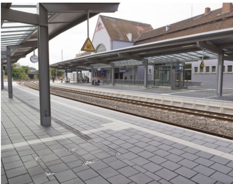
Bahnsteig in 30/30/8 cm mit Beschichtung RSF 5 mit Teflon® Oberflächenschutz
