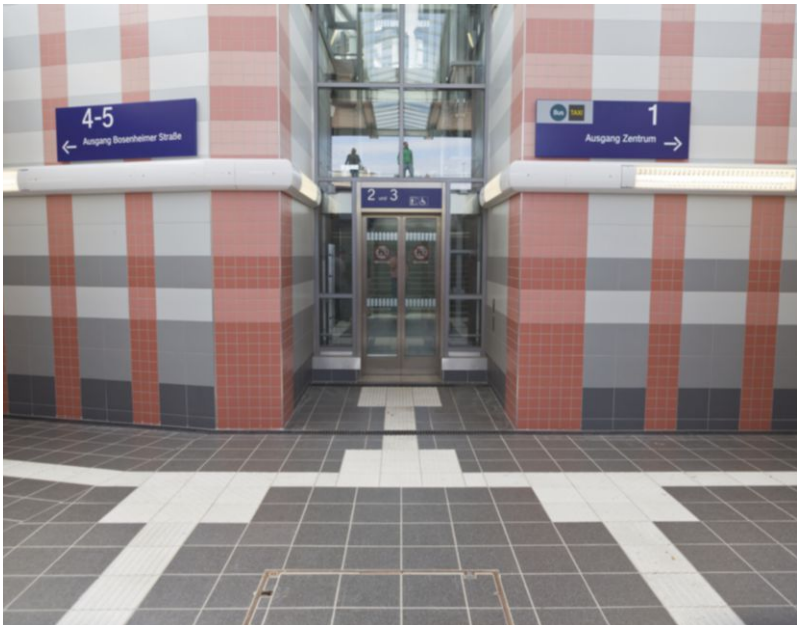
Personenunterführung in 30/30/3,8 cm terralit Luna mit Beschichtung RSF 5 mit Teflon® Oberflächenschutz.
