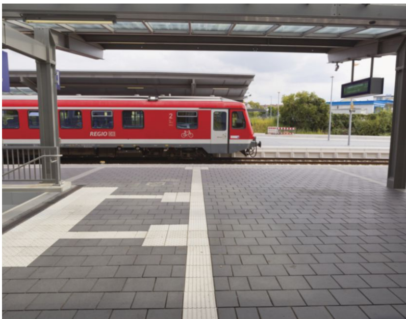
Aufmerksamkeitsfeld vor dem Treppenabgang zur Personunterführung
