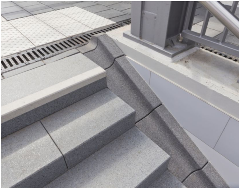
Stufenanlage mit Fahrradspur
