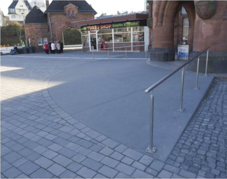
Barrierefreier Zugang durch radiale Sonderteile in rinnit Basalt.
