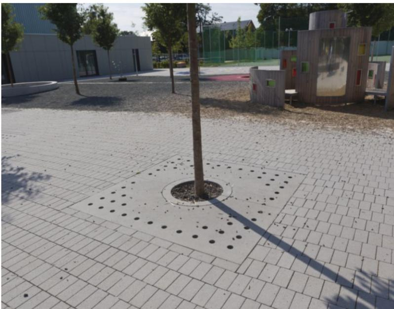
Baumscheibe in Sonderfertigung 200/200/12 cm. Die Oberfläche der Baumscheibe wurde passend zum angrenzenden Pflaster gefertigt.
