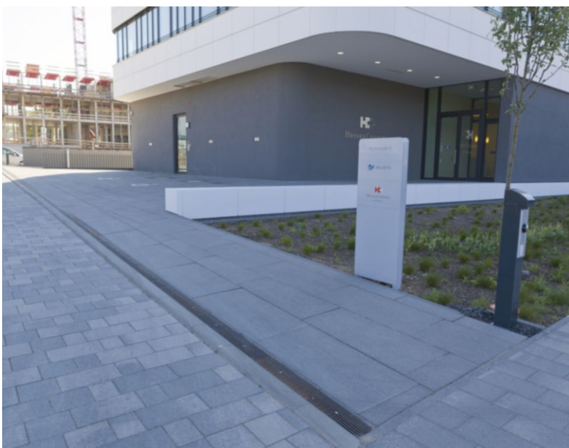
Eingangsbereich fußläufig mit Großformatplatten und Pflaster in der Fahrbahn.
