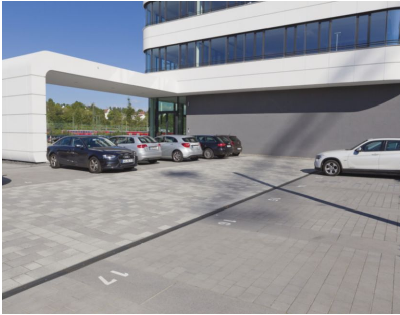
Die Parkplätze der Mitarbeiter gestaltet mit Siliton Anthrazit heben sich farblich ab.
