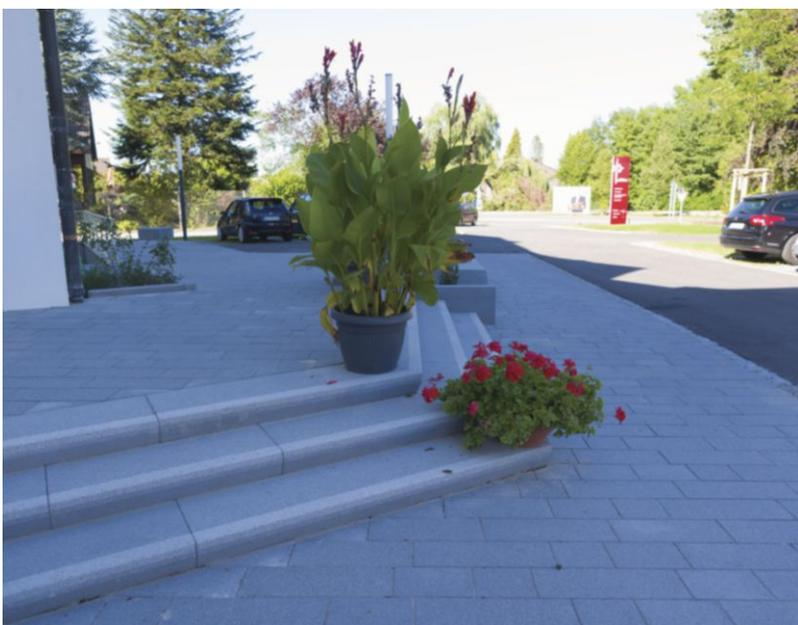
Treppenausführung mit Bi-Color Stufen in rinnit Platin dunkel mit Einleger in rinnit Platin hell
