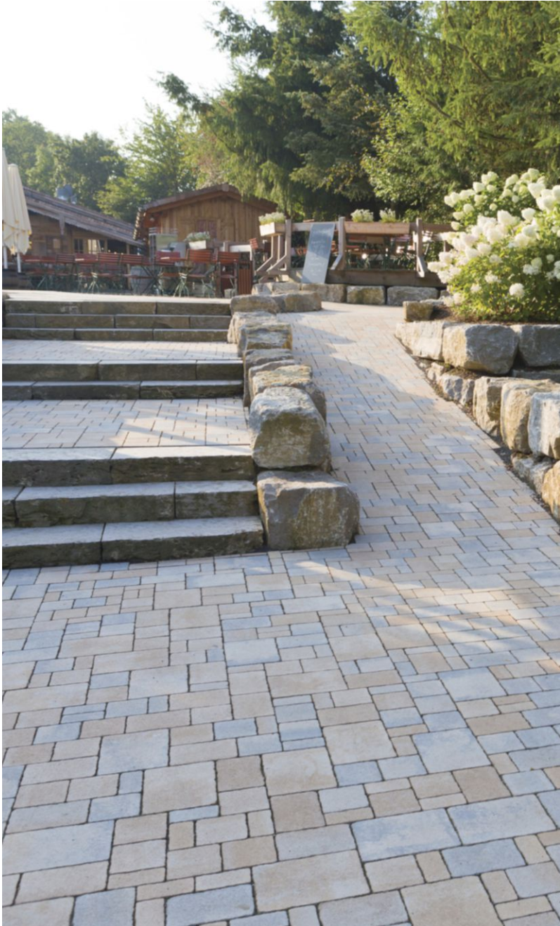
Die Treppenanlage und eine barrierefreie Rampe aus Altstadt-pflaster führen zur Q-Alm hoch.
