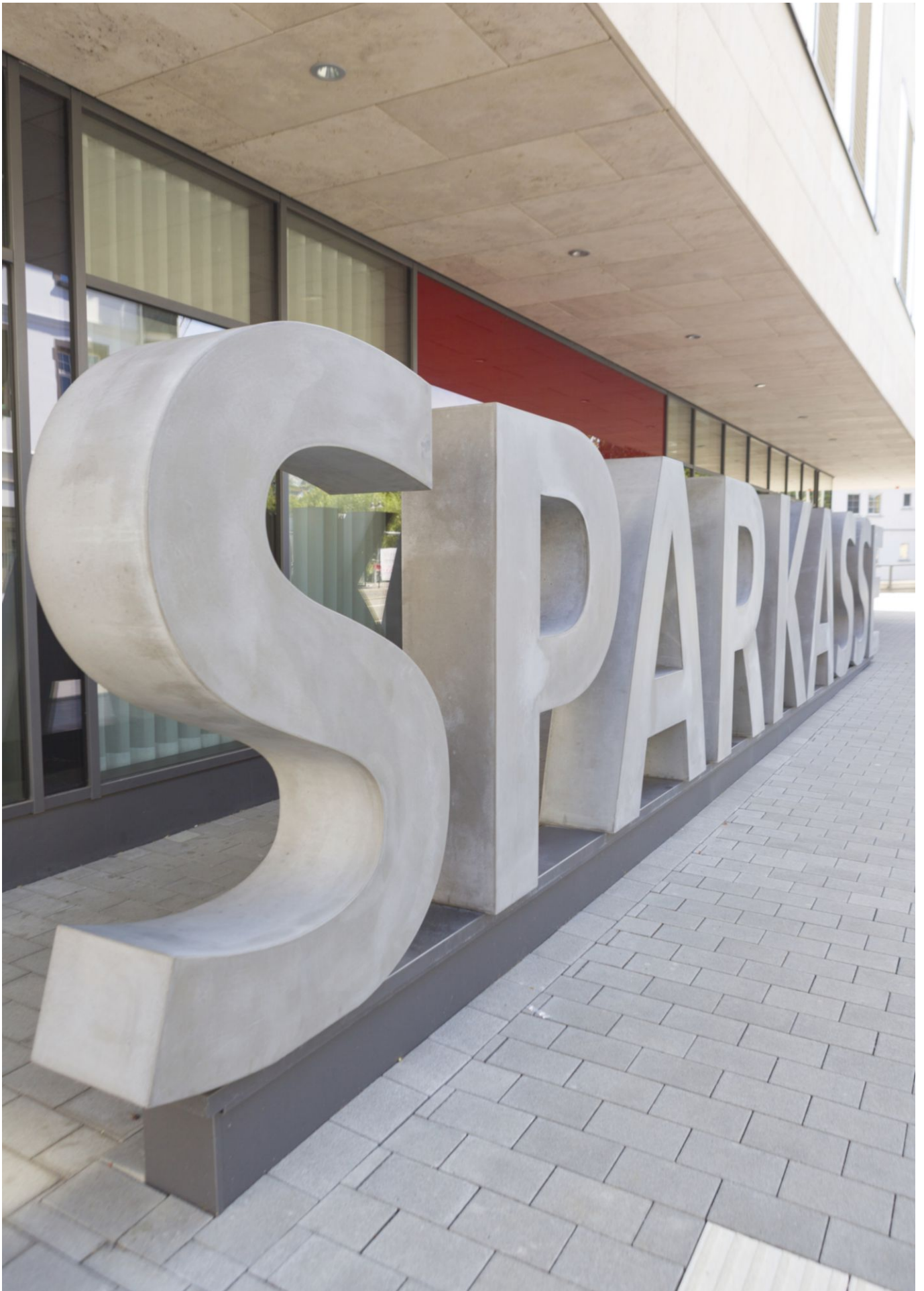
Die Vorderseite der Buchstaben mit einer glatt geschalteten Sichtbetonoberfläche zeigt in Straßenrichtung.
