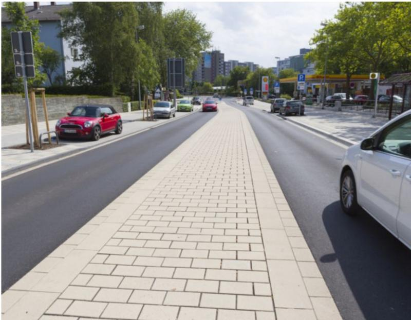
Die je einspurigen Fahrspuren werden von einem Pflasterstreifen getrennt.
