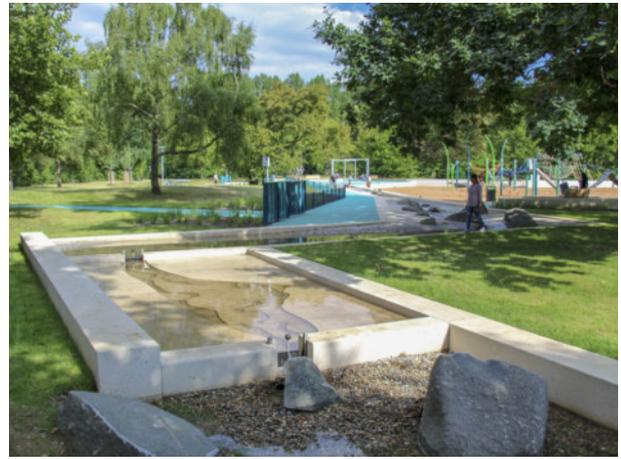
Sonderanfertigungen in der rinnit Oberfläche bilden das Becken für den Wasserlauf, der aus verschiedenen Quellen gespeist wird und durch den gesamten Spielplatz Richtung Wöhrder See geführt wird.
