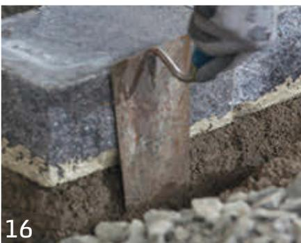
16 Der Beton muss einseitig bzw. beidseitig zu späteren Pflasterflächen hin abgestochen werden, um einen gleichmäßigen Aufbau des Unterbaus zu gewährleisten. Sollen die angrenzenden Flächen der freistehenden Mauer unbefestigt hergestellt werden, ist auf der betreffenden Seite jeweils eine Rückenstütze herzustellen.
