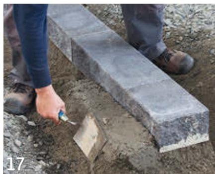
17 Die Rückenstütze sollte min. 10 cm breit sein und den Stein zu einem Drittel einbinden. Sie ist mit Gefälle weg vom Bauwerk anzulegen, um eindringendes Wasser zur Drainageschicht hin abzuführen. Soll die Mauer mit Drainbeton hinterfüllt werden, ist die Rückenstütze der Stärke der Drainbetonschicht entsprechend auszuführen.
