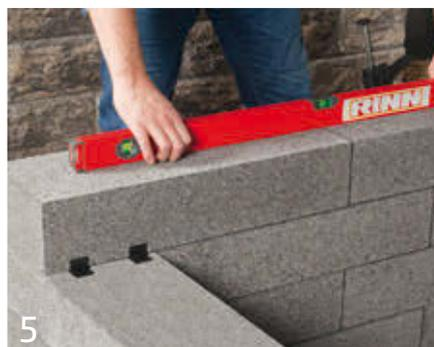
Überprüfen Sie Stein für Stein die Flucht in allen Achsen, horizontal und vertikal über die ganze Mauer hinweg
