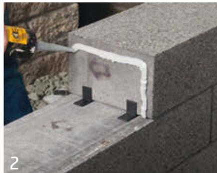
Tragen Sie auf den Kopfseiten den Kleber U-förmig mit ca 2 cm Abstand zum Steinrand auf. So wird die Fuge geschlossen.
