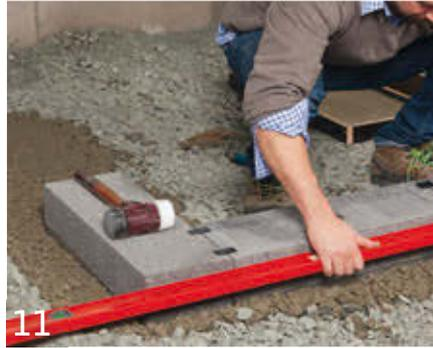
11 Flucht mittels Richtlatte oder Schnur kontrollieren.
