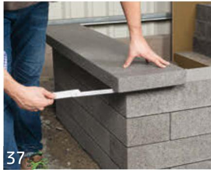
Zum Abschluss die Mauerabdeckung setzen. Diese mittig setzen mit jeweils 5 cm Überstand zur Mauer. Für den Anfang der Mauer und die Mauerecke steht eine Mauerabdeckung Kopf mit bearbeiteter Seite zur Verfügung.
