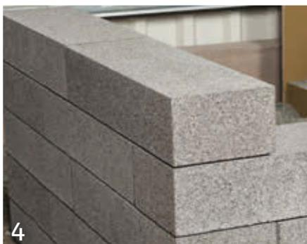
Kombisteine sind 3 mm kürzer als die Normalsteine. Die Differenz muss über die Stoßfugen ausgeglichen werden.
