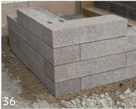
Ein exaktes Arbeiten, Stein für Stein, garantiert den geraden Aufbau der Mauer bis zur letzten Steinreihe.
