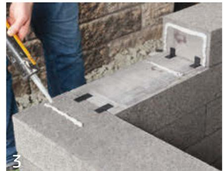
Arbeiten Sie beim Setzen der Abdecksteine im Übrigen wie bei den Mauerreihen.
