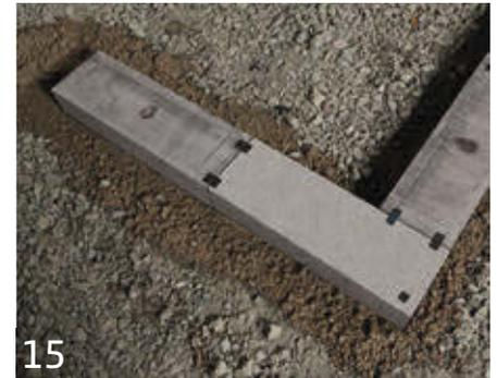
15 Nach Fertigstellung der ersten Reihe wird nochmals in Längs- und Querrichtung gefluchtet und ausgerichtet. Anschließend warten, bis der Fundamentbeton leicht angezogen hat.
