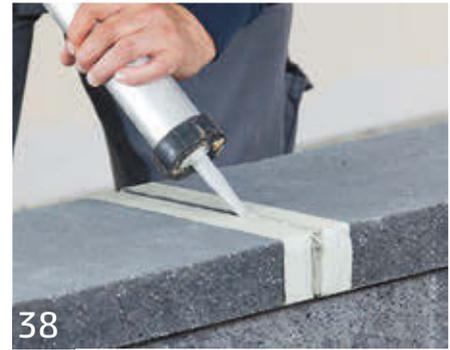
Anschließend ist die Fuge abzukleben und mit einem für den Außenbereich geeigneten, dauerelastischen Fugenfüllstoff (Natursteinsilikon) zu verschließen. Alternativ kann hierfür auch der mitgelieferte Kleber verwendet werden.
