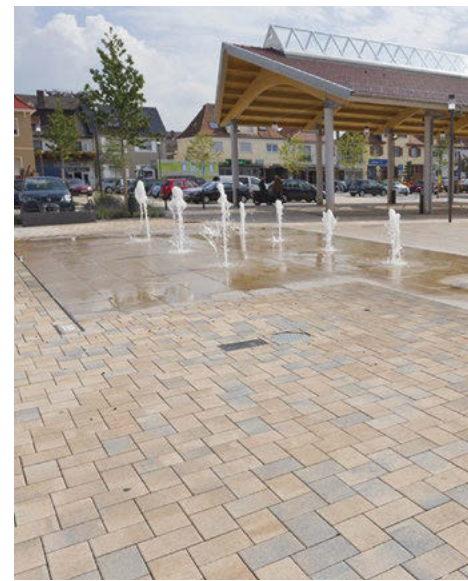
Oben: Objekt: Fahrstraße Hanau Produkt: Magnum Silton Format: 32 x 16 x 18 cm,
