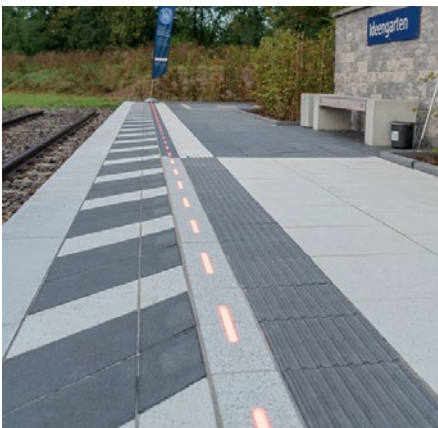
Abb. 3: Lichtmuster in Rot warnen Reisende vor ein- oder durchfahrenden Zügen.
