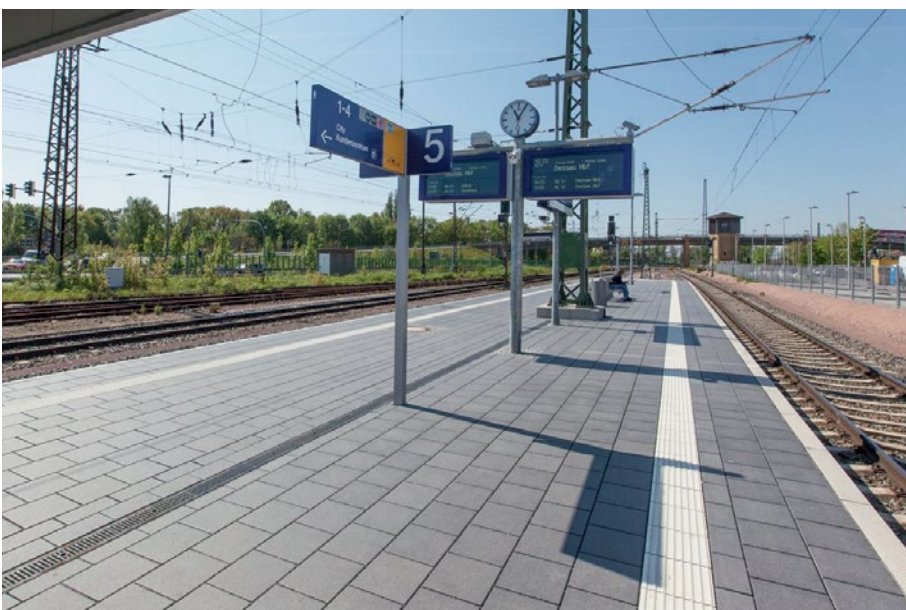
Abb. 6: Grüner Bahnhof Lutherstadt Wittenberg – Bahnhof des Jahres 2017 – u. a. mit Quadratpflaster 30/30/8 cm Standard Anthrazit mit 40 % Recyclinganteil
