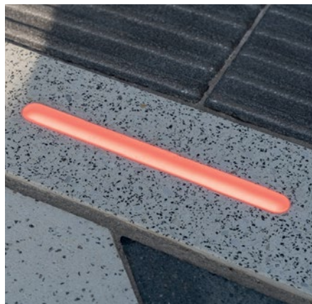
Abb. 4: Mit integriertem Lichtleitkörper wird Beton zum Informationsmedium.
