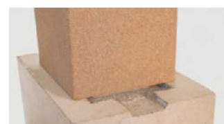
Fundamentansatz in Einzelfundamentschale mit Beton verfüllt.
