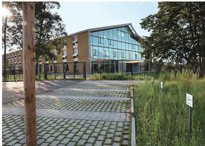
Hydropor Siliton - umlaufende Grünfuge 30 mm
